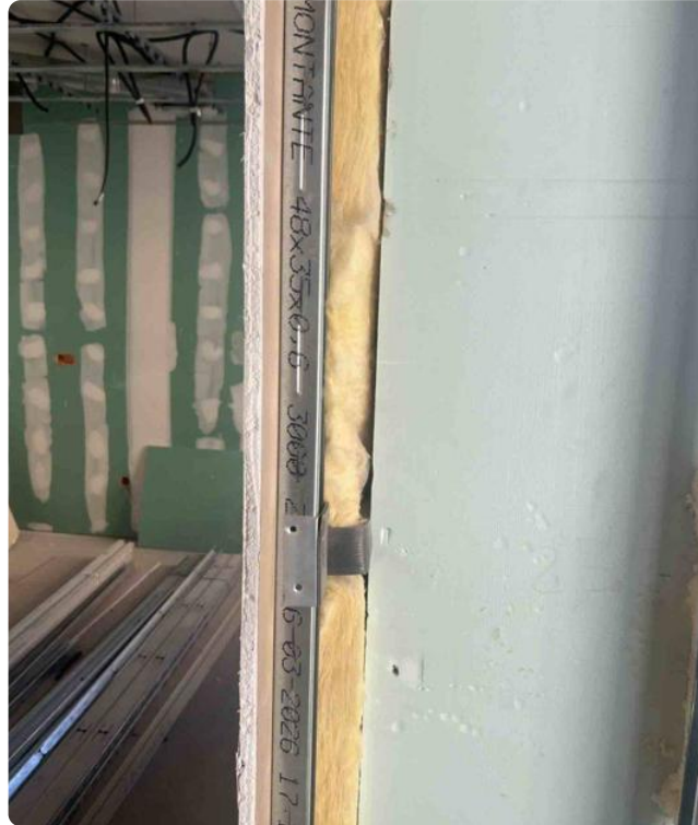
Aislamiento de lana de roca. Septiembre 2026.
