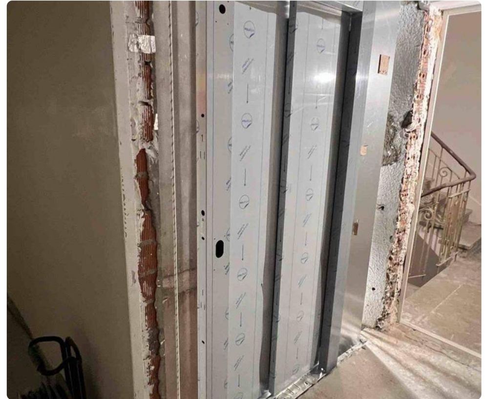
Montaje del ascensor. Obra, octubre 2026.
