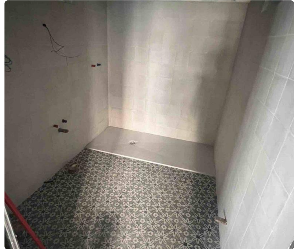
Baño en ejecución. Octubre 2026.
